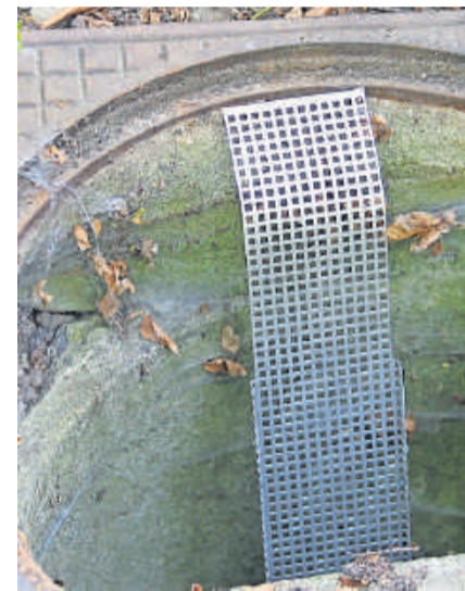
Entlang der Lochblechschiene können Amphibien hochklettern.
