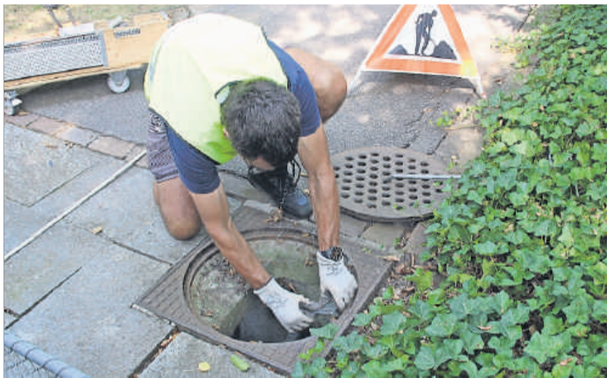
Peter Maag installiert in vier Gullys Lochblechschienen, die den Amphibien den Ausstieg aus Strassenschächten ermöglichen. Fotos: Annina Just
